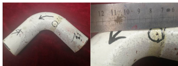
图1 焊接弯管腐蚀穿孔宏观照片
