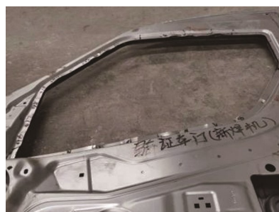
(a)玻璃框处焊点凿检
