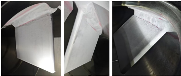
图3 整流板焊缝PT检测显示
